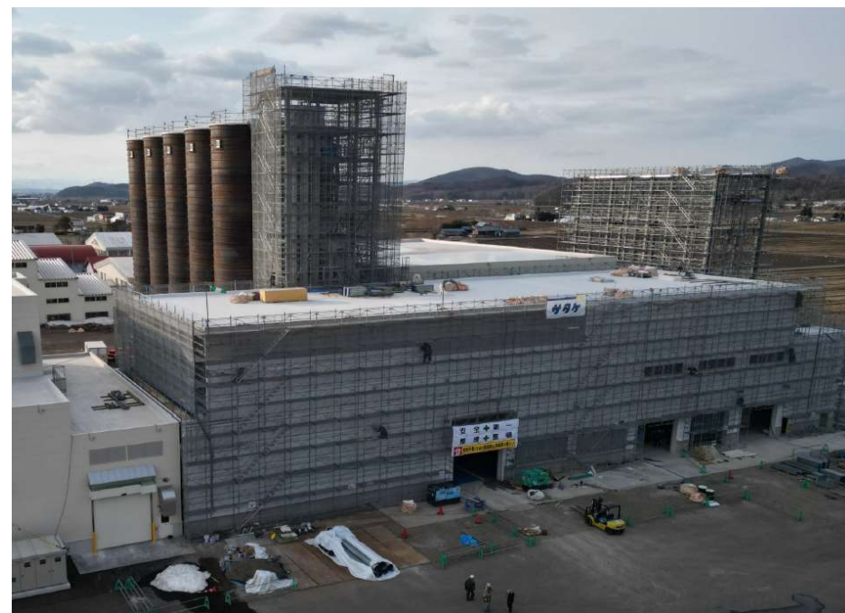
機械棟・サイロ等（工事中）
