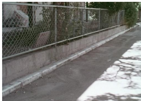
(下水道整備後)
