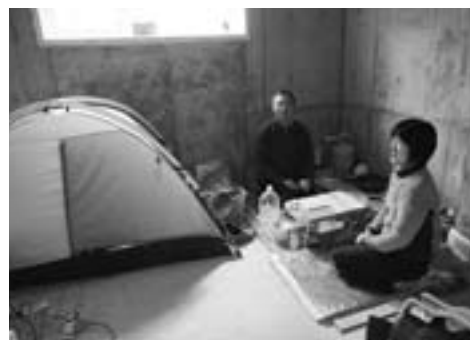
1階コンクリート基礎部の納戸スペースに泊まり込んで建設中(登山用テント、キャンプ用品が役立っています)
