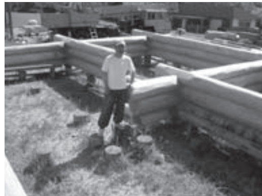
輸入したログ材を仮組みし始めて2年目の春(昨年6月26日、北広島市内のログハウス建材輸入会社の作業場)
