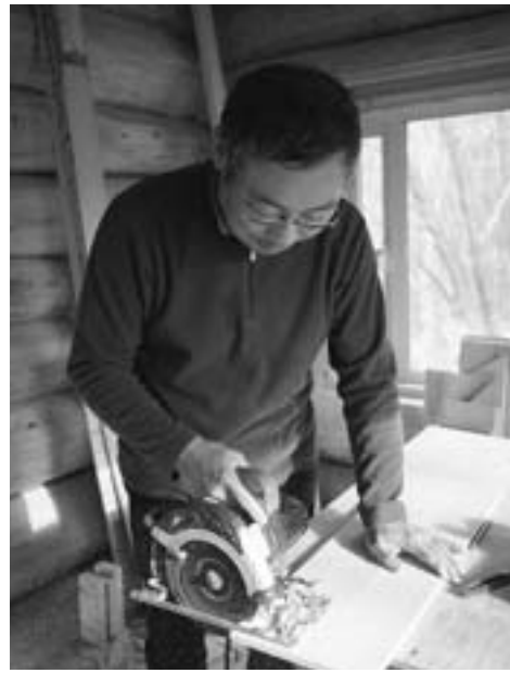
内装作業が旧ビッチの室内(約12畳ほどの広さがある1階カフェスペース)
