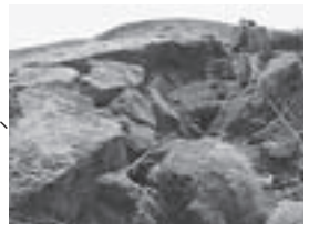
大きく崩壊した登山道。「間宮城」はこの跡地に造成された(2011年9月11日撮影)
