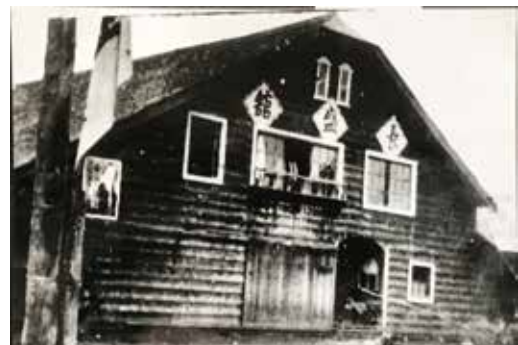
流感の被害が出ていた1925年(大正14年)に東川村西4号南2番地に開業した劇場「長盛館」。このころの人口は今と同じ約8300人で、市街地はにぎわっていた。
