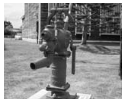
手押しのでこ支え金具が切断されたポンプ
