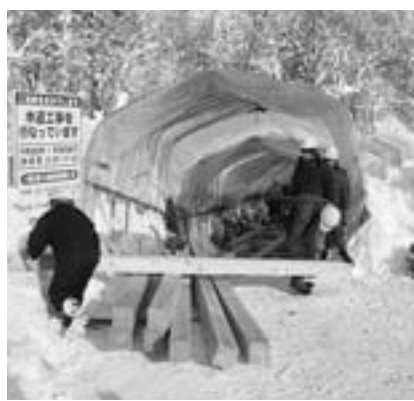
降雪の中行われた木道取り付け工事(昨年12月)
