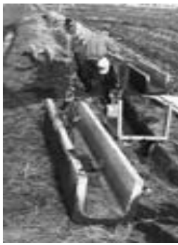
▶用排水路の補修工事(35区)
